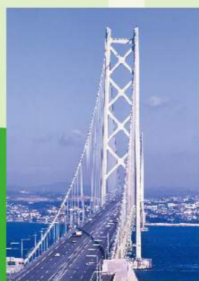
明石海峡大橋
